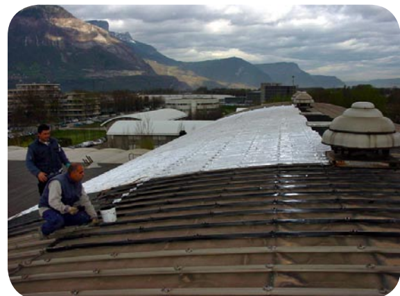
Figure 3 : Travaux d'étanchéité sur la toiture du bâtiment 8.
