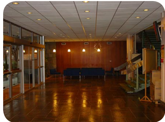
Figure 2 : Les nouveaux faux-plafonds de l'entrée principale.
