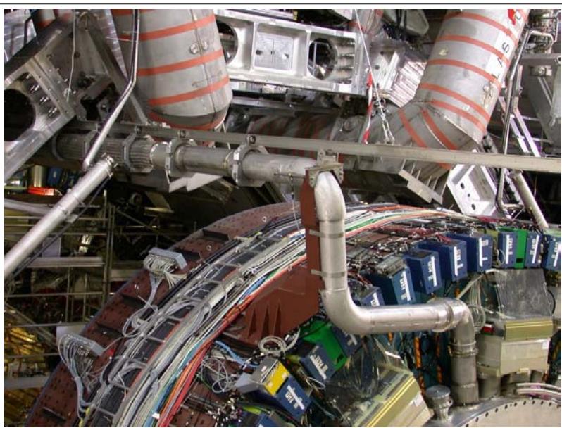
Intégration dans la caverne UX15 d'ATLAS : Ligne argon liquide dans son système de guidage lors du déplacement du End-Cap A maintenu en froid
