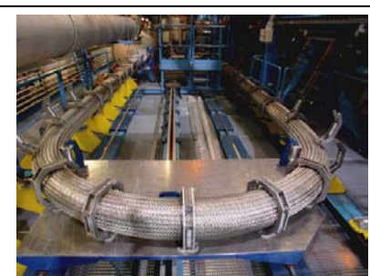
Ligne DN150 dans son système de guidage sur la plateforme
