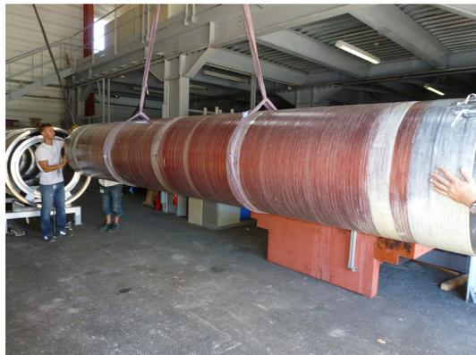
Fig. 2: Installation du solénoïde dans le blindage.
