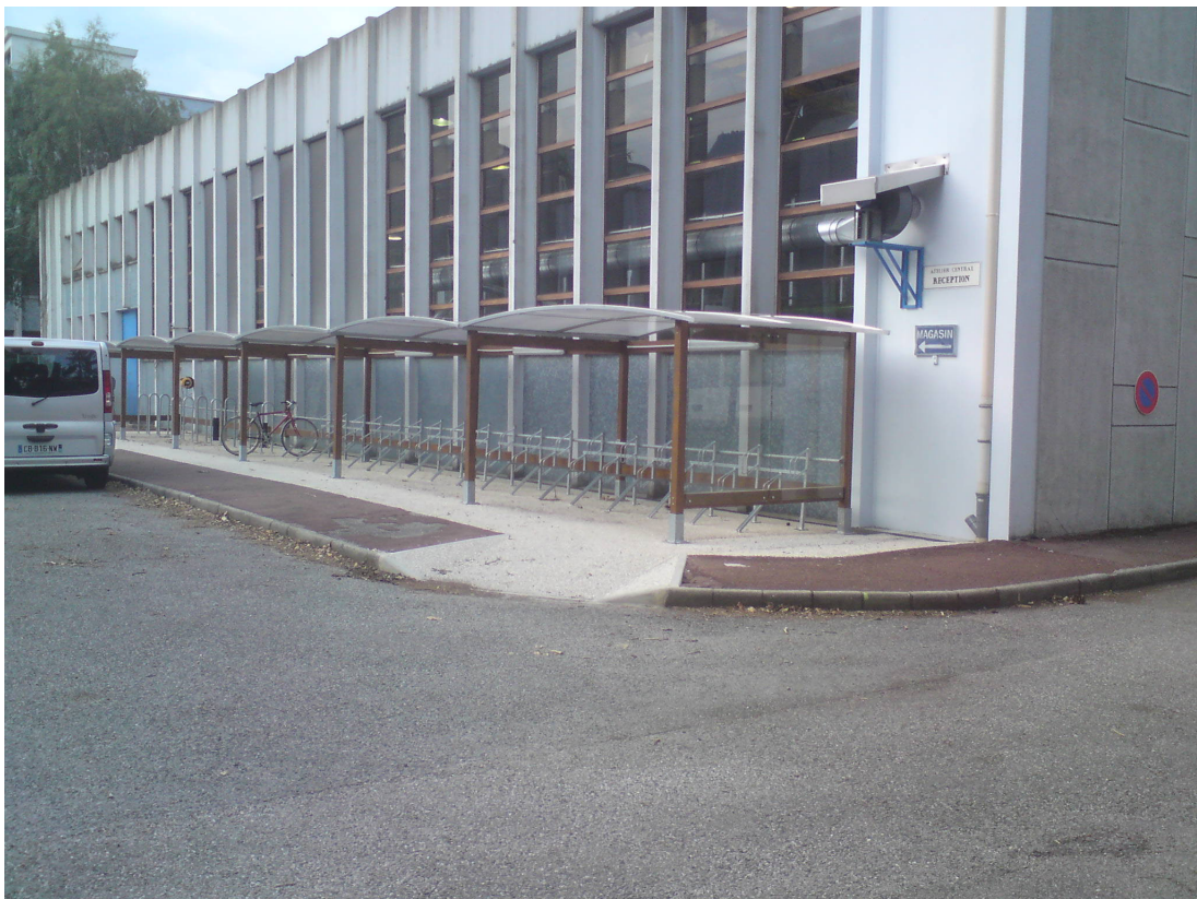
Photo 2 : Le nouvel abri vélos.
