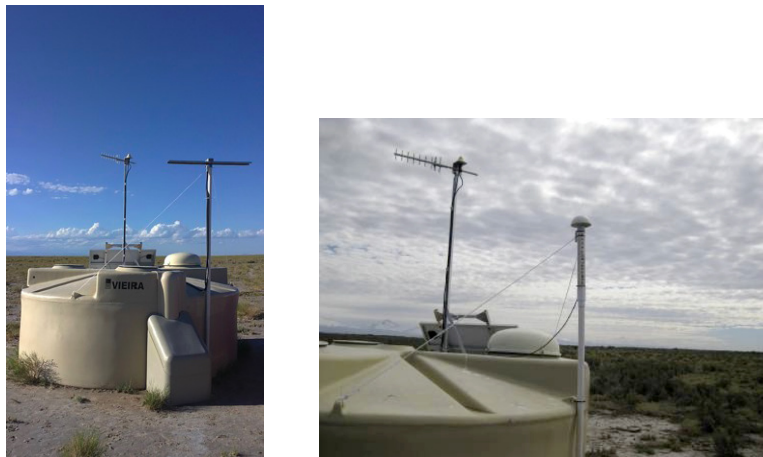
Fig. 4: Installation d'antennes sur les cuves Cherenkov du réseau au sol de l'Observatoire Pierre Auger, à gauche dans le domaine du MHz (30 à 80 MHz) et à droite dans le domaine du GHz (3 à 5 GHz).
