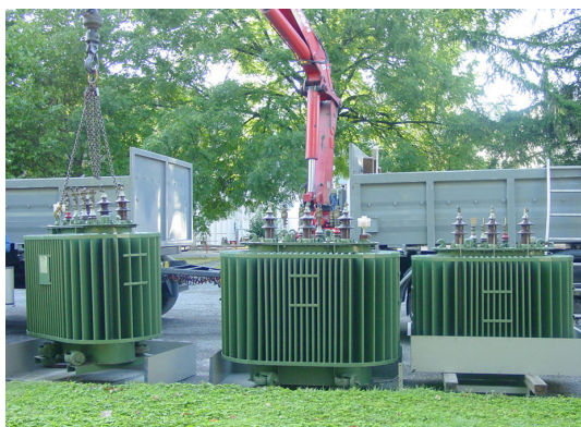
Photo 1 : Évacuation des transformateurs au PCB.
