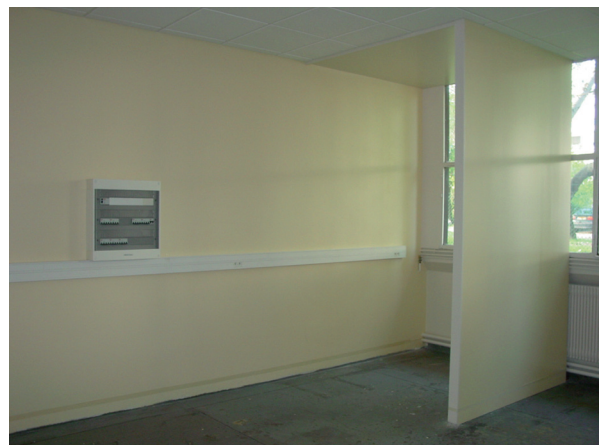
Photo 2 : Recâblage de l'atelier de valorisation.
