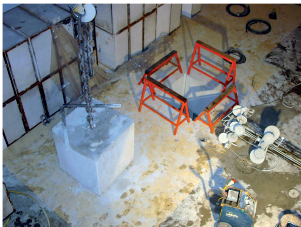
Photo 1 : Perçage de la dalle de l'expérience GUINEVERE.
