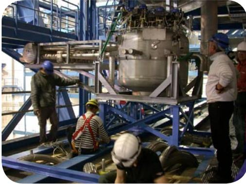
*Figure 2: Installation boîte à vanne azote du Barrel (caverne ATLAS, CERN).*
