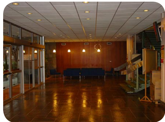
Figure 2 : Les nouveaux faux-plafonds de l'entrée principale.
