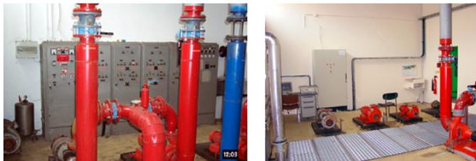
Figures 5 : a) L'ancienne armoire de commande ; b) la nouvelle.
