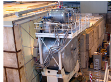
Figure 1 : Équipements cryogéniques du End-Cap C de l'expérience ATLAS (hall 180, CERN).
